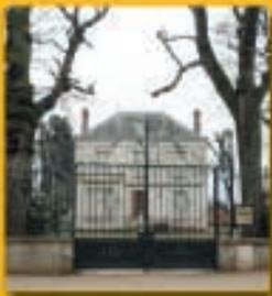
Les clôtures permettent de reconstituer l'alignement urbain. Elles ont une importance prépondérante dans la lecture du paysage urbain. Elles sont constituées d'un mur bahut en maçonnerie, recouvert ou non d'un enduit. Ce mur est surmonté d'une grille en ferronnerie souvent très travaillée.
