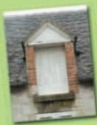
**Lucarne pendante dite "feunière"** qui permettait d'installer le foin dans les combles du bâtiment, servant ainsi d'isolation au corps de logis. Ce type de lucarne nécessitant aujourd'hui l'installation de 2
