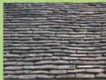
**Les couvertures doivent être refaites en tuiles plates de terre cuite petit moule (45 à 92 au m<sup>2</sup>) de teinte rouge vieilli. Les bruns chocolat sont à proscrire.**
