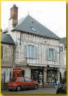
L'ossature était à l'origine recouverte d'un lattis de bois et remplie d'un mortier de terre et de fragments calcaires. Le parement était un enduit à base de chaux aérienne et plâtre. Ces enduits anciens ont presque tous disparu, au cours du XX<sup>ème</sup> siècle, au profit d'enduit ciment.
