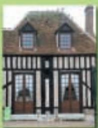
**Les constructions à pans de bois sont en général destinées à être recouvertes d'un enduit de parement à base de chaux aérienne qui protège les bois.**
