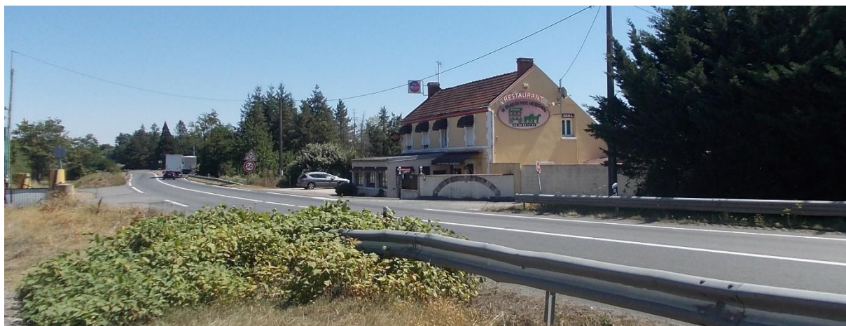
Figure 13 - Vue sur le restaurant "Relais du Pont des Beniers", depuis la RD 2060, en arrivant de Châteauneuf-sur-Loire (Terr&Am)
