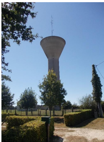
Figure 18 - Le château d'eau de Sury-aux-Bois (Terr&Am)
