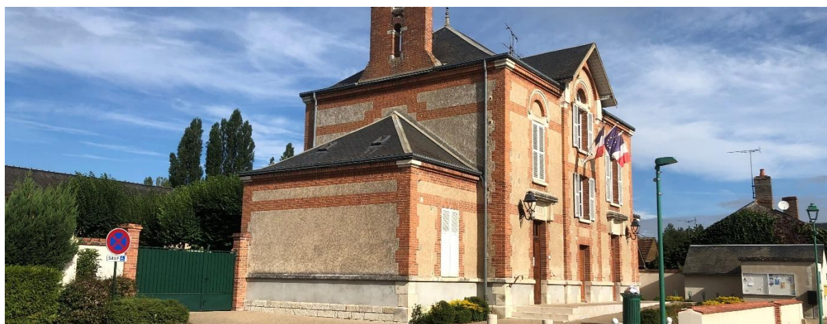
Figure 27 - La mairie de Sury-aux-Bois (Terr&Am)
