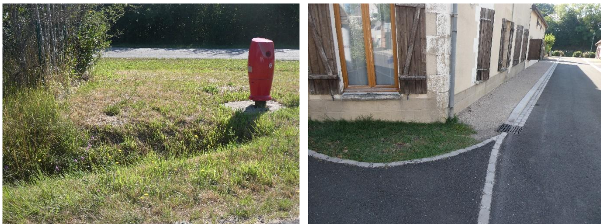
Figure 55 - Fossé de collecte des eaux pluviales (à gauche) et exemple d'un revêtement de trottoirs (à droite) (IEA)
