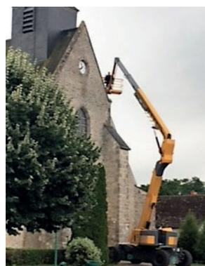
La réparation des dégâts causés par la tempête a nécessité le recours à une nacelle qui a permis à l'entreprise en charge des travaux de procéder au remplacement des ardoises arrachées ou cassées, la repose à d'un abat-son en zinc envolé, à la réparation des châssis des ouvertures du toit.
